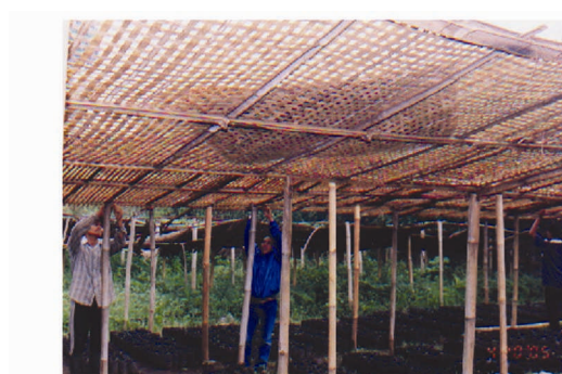
b. Pembuatan Naungan/Bedengan
